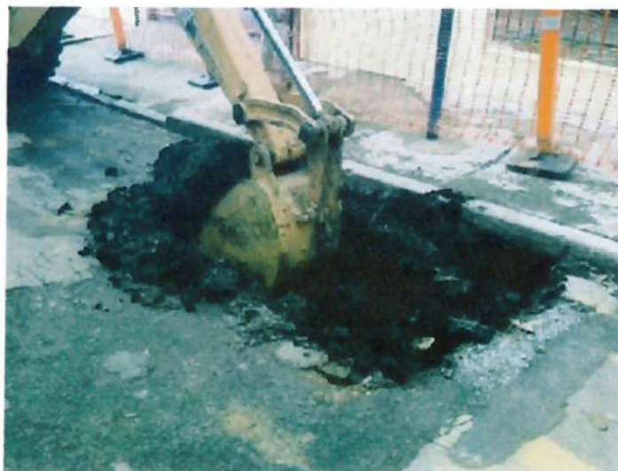
Figura 3: Início do processo de escavação
