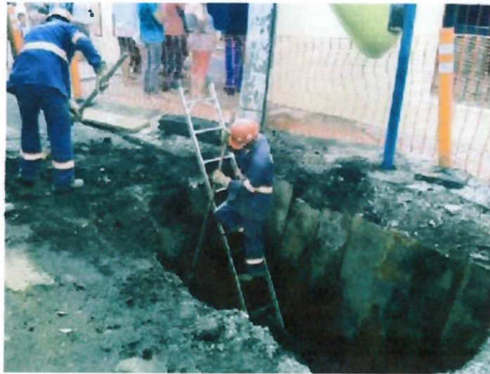
Figura 5: Abertura da vala de 2,10 x 2,50 de profundidade
