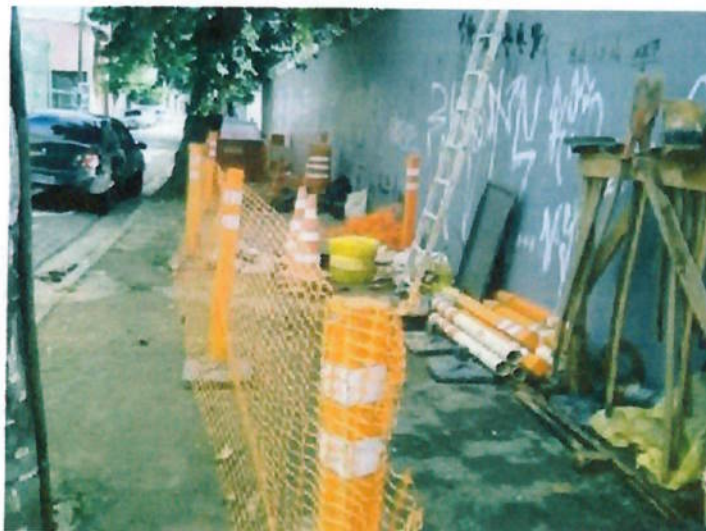
Figura 1: Início da escavação – preparação do canteiro provisório de obra
