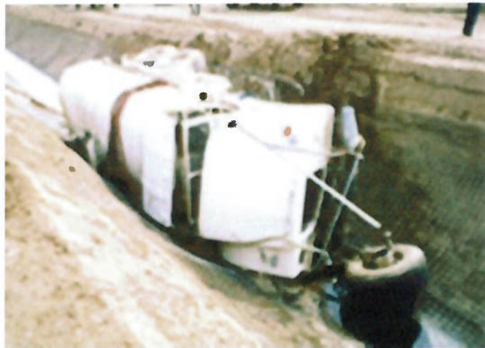
Figura 11: Acidente com veículo (caminhão) por falta de proteção e sinalização nos taludes.
