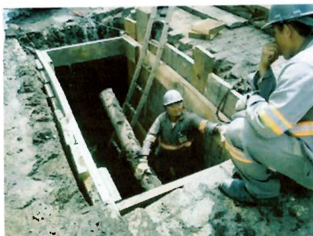
Figura 10 - Abertura de Vala
