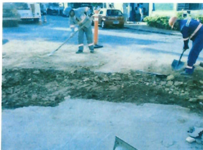
Figura 8: Finalização da escavação com a compactação do solo
