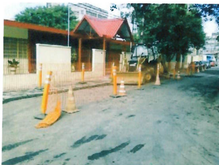
Figura 2: Sinalização de advertência e barreiras de isolamento
