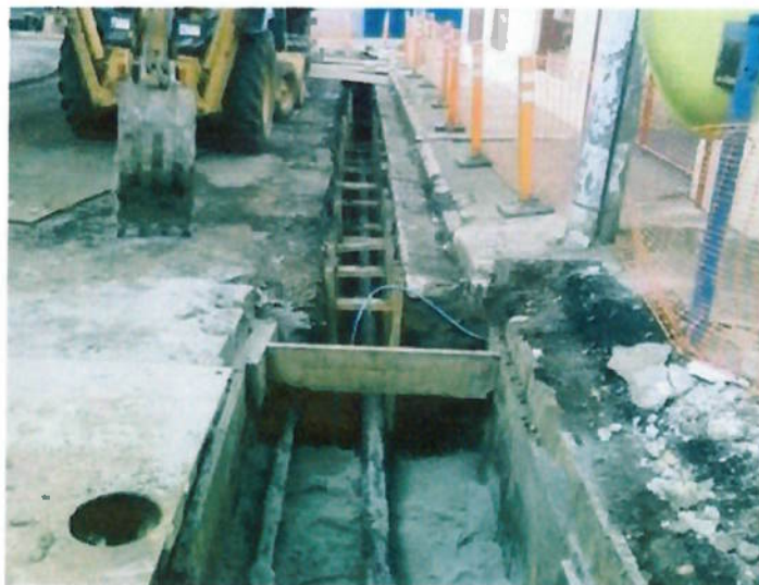
Figura 7: Finalização do escoramento
