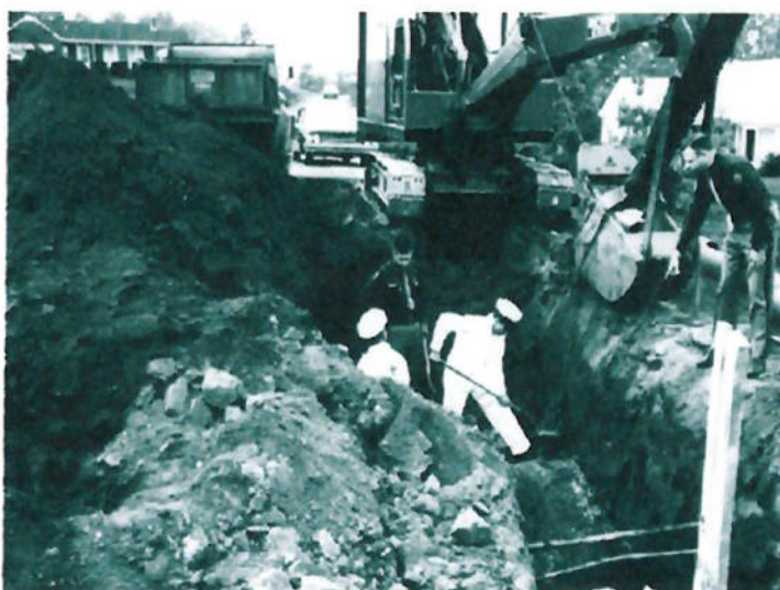
Figura 10: Escavação de vala com retro-escavadeira operando próxima à vala.
