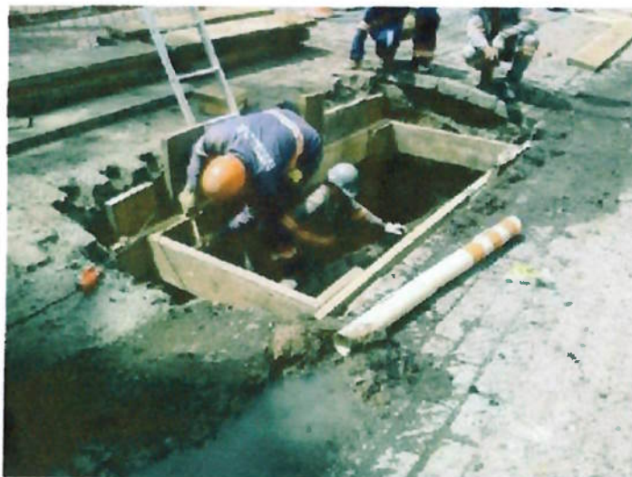
Figura 6: Escoramento da vala com pranchas de madeira na vertical e longarinas na horizontal.
