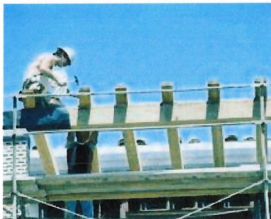
Figura 1 - Operário movimentando-se em altura durante execução de obra. Fonte: Edifício em construção Guarujá 2008
